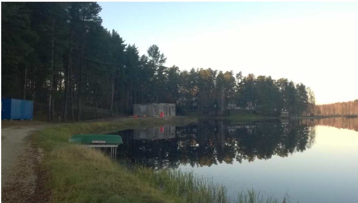
Fotofiksācija. Skats uz eliņa (laivas mājas) būvobjektu Lokālplānojuma teritorijā un esošo ceļu gar dīķa piekrasti
