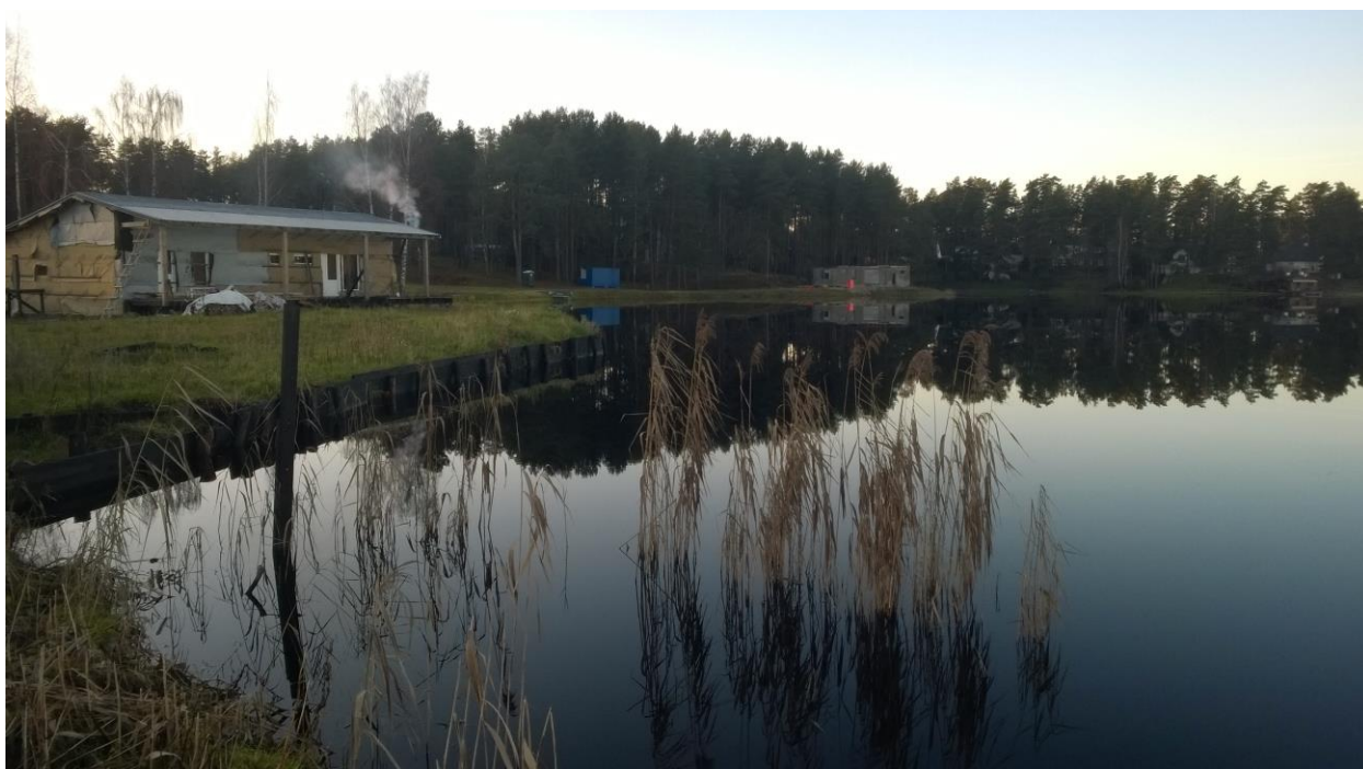
Fotofiksācija. Skats uz Upesciema dīķa piekrastes ainavu ar ūdensmalas izmantošanu saistītām būvēm
