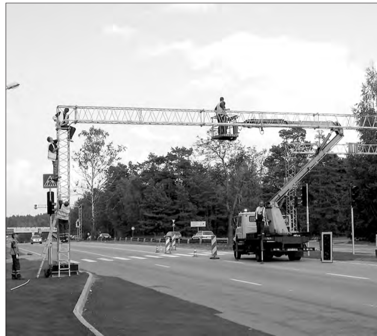
Tiek montēti luksofori pie metāla konstrukcijām.
